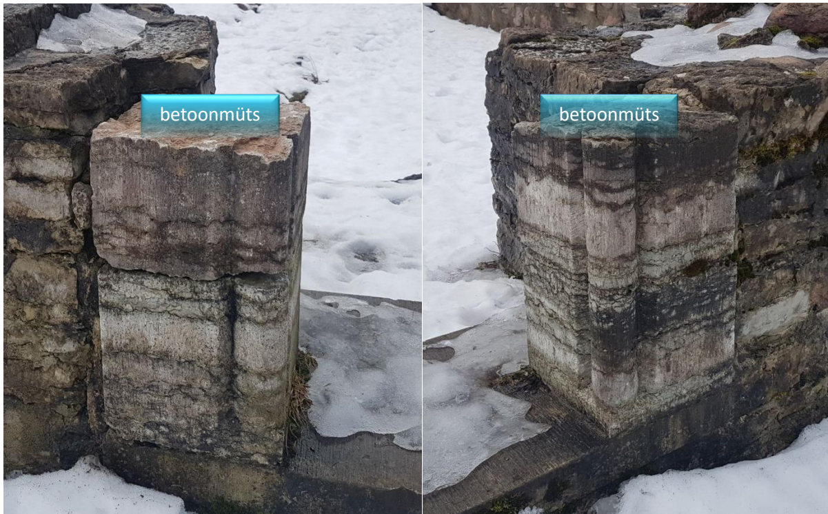
Foto. 6. Vaade portaali tahutud postidele. Katta eraldi betoon „mütsiga“.
