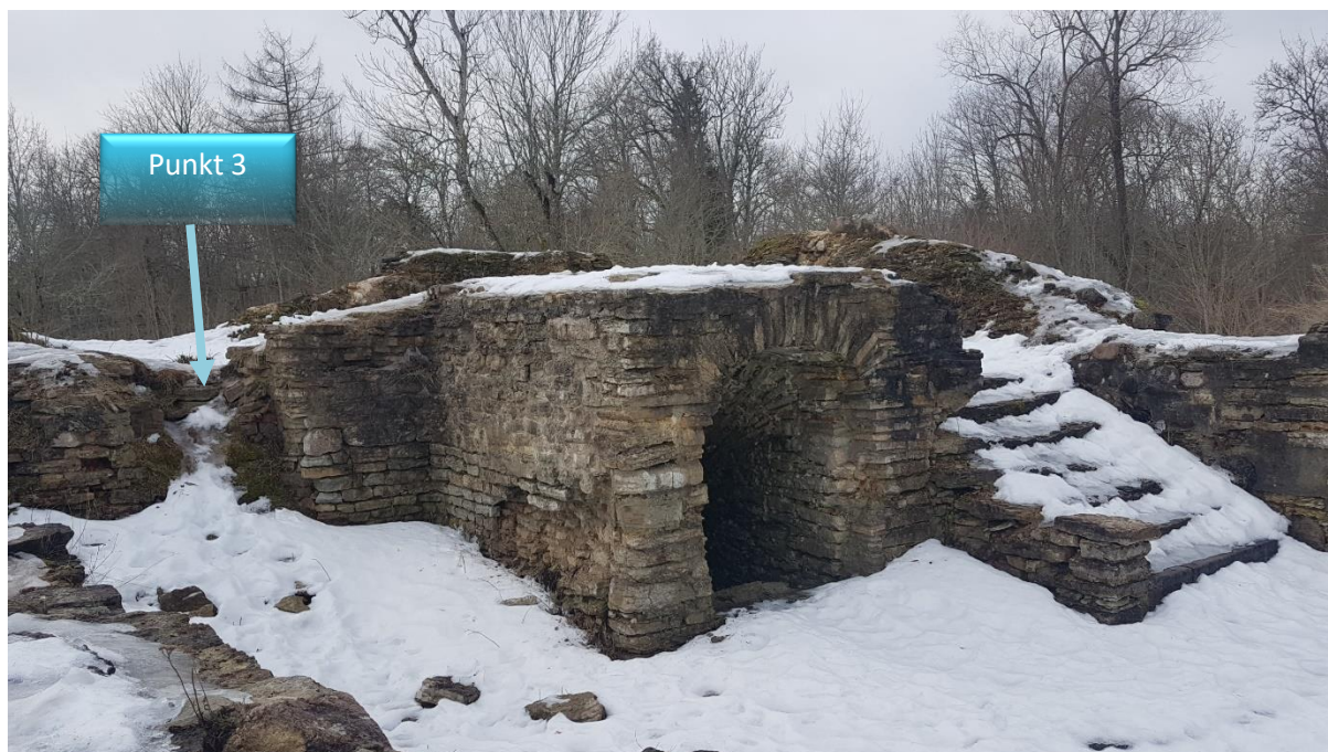
Foto 16. Vaade keldri sissepääsu avausele ja trepile.
