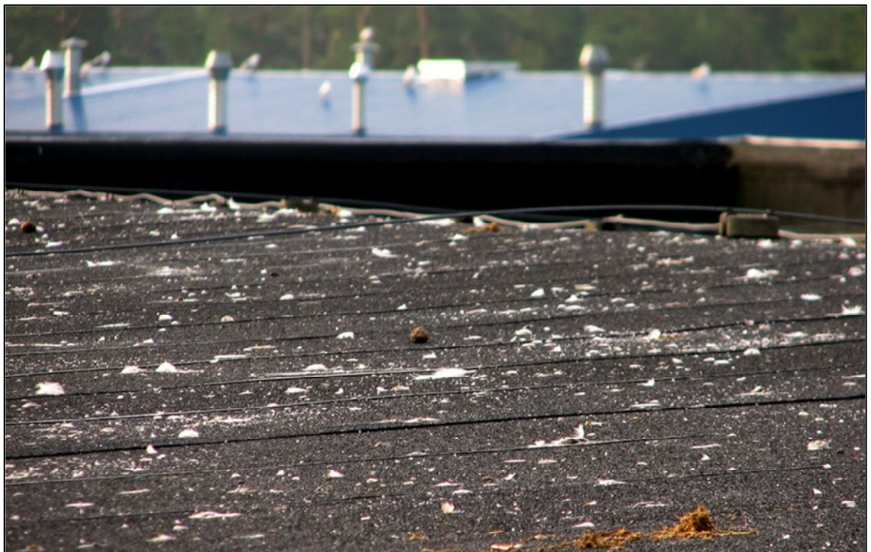
Joonis 22. Harju KEKi territooriumil asuva hoone katus peale kajakate ööbimist. Väljaheited, suled ja Karjaküla karusloomakasvatusest sisse ahmitud ja hiljem välja oksendatud põhu ja saepuru segu tekitab hoonete katuste äravoolukanalites ummistusi, põhjustades vee kogunemist katusele.
