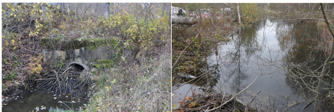
Foto 7. Ummistunud truup ja sellest tingitud üleujutus Tööstuse 5, 7 ja Linnamäe tee 16 juures
